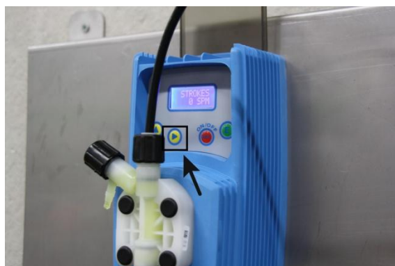
Afbeelding 11: Persleiding vullen
