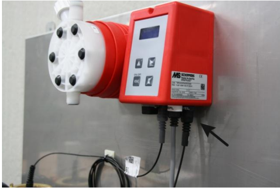
Afbeelding 5: Aansluiten droogloopbeveiliging
