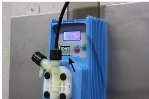
Imagen 11: Llenar el conducto de presión
