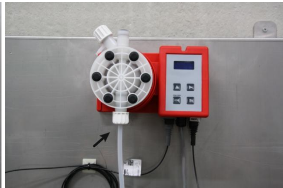
Imagen 6: Conectar tubo flexible aspiración
