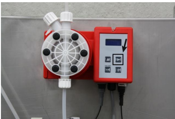
Imagen 15: Llenar el conducto de presión
