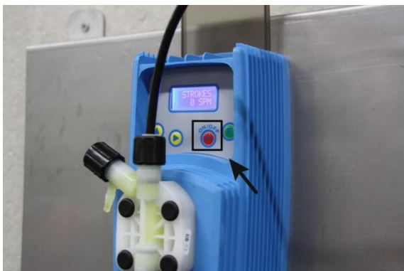
Figura 8: Avviare la pompa
