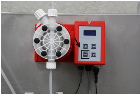
Figura 12: Avviare la pompa
