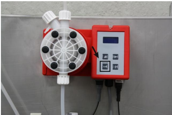
Figur 12: Tænd for pumpen
