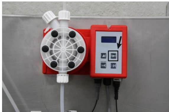
Figur 15: Trykslangen fyldes
