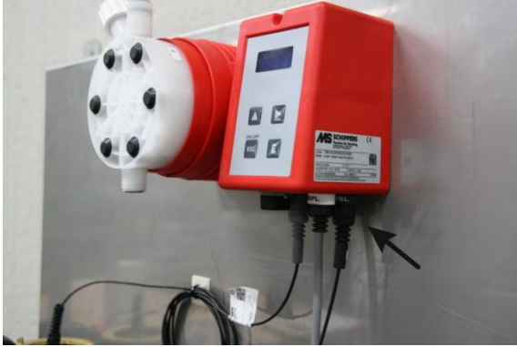
Figur 5: Tilslut tørkøringsbeskyttelsen
