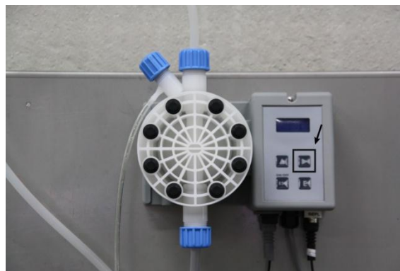
Figura 8: Riempire il condotto in pressione
