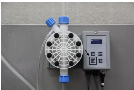
Figur 5: Tænd for pumpen
