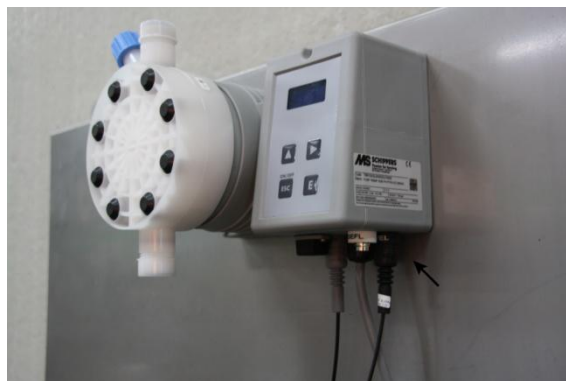
Figur 2: Tilslut tørkøringsbeskyttelsen
