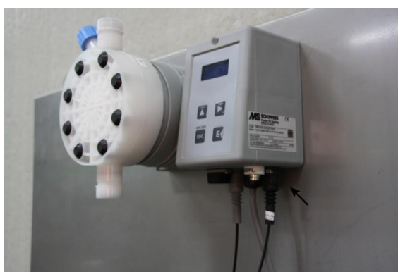
Imagen 2: Conectar protección funcionamiento seco
