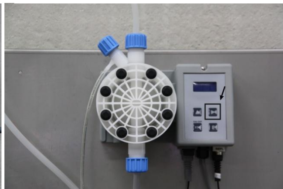
Imagen 8: Llenar el conducto de presión
