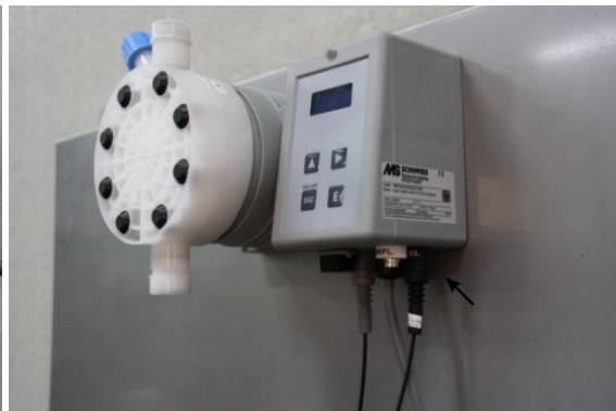
III. 2: Raccorder la sécurité anti assèchement
