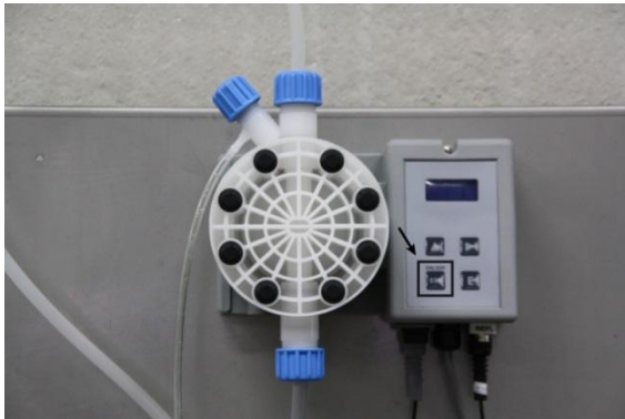
III. 5: Mettre la pompe sous tension
