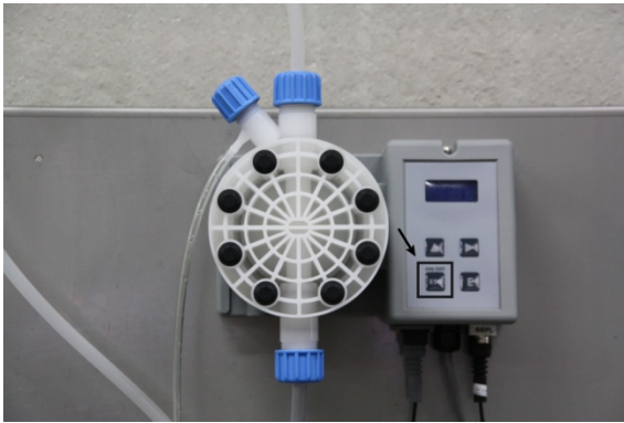
Abbildung 7: Pumpe einschalten
