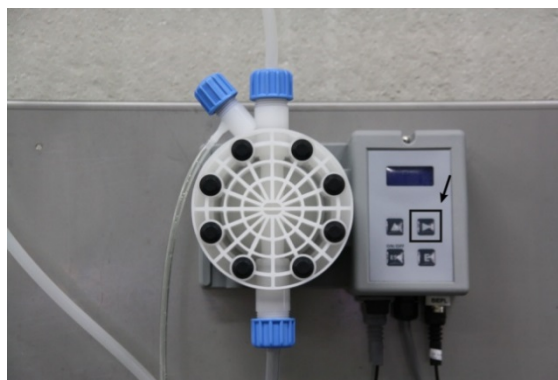
Ill. 10: Remplir la tubulure de sortie
