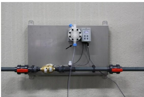
Afbeelding 5: Aansluiten aanzuigslang
