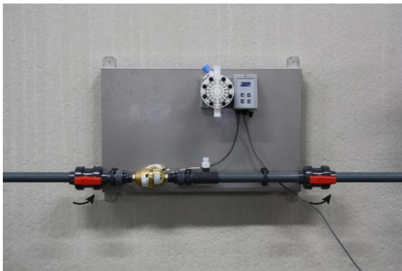
Afbeelding 1: Opendraaien kogelkranen
