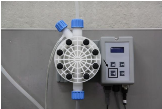
Afbeelding 7: Aanzetten van de pomp
