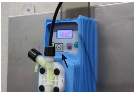
III. 8: Remplir la tubulure de sortie
