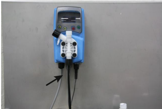
Figur 3: Tilkobl sugeslangen
