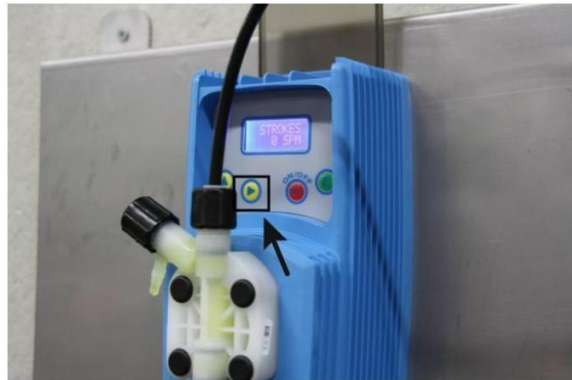
Abbildung 8: Druckluftschlauch befüllen
