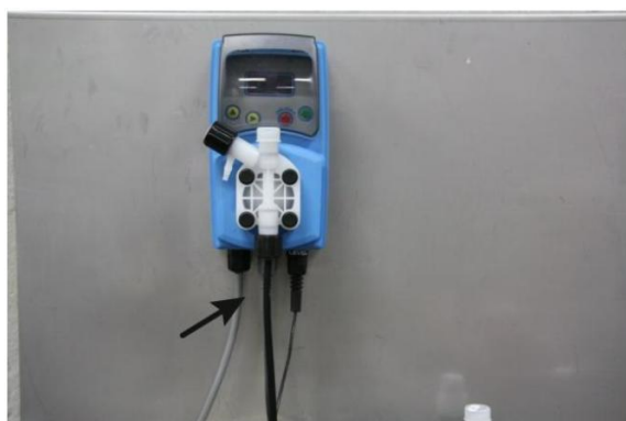
Ill. 3: Raccorder le tuyau d'arrivée
