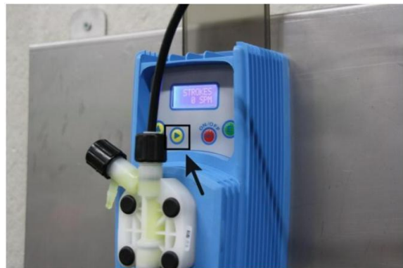
Ill. 8: Remplir la tubulure de sortie
