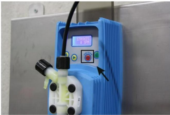
Ill. 5: Mettre la pompe sous tension
