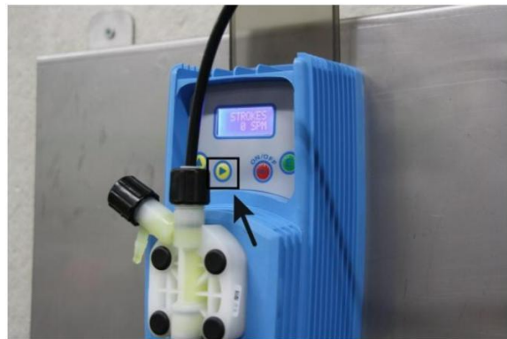
Abbildung 8: Druckluftschlauch befüllen
