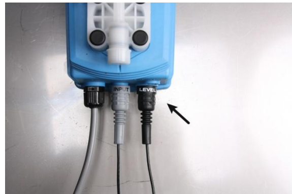
Imagen 2: Conectar protección funcionamiento seco
