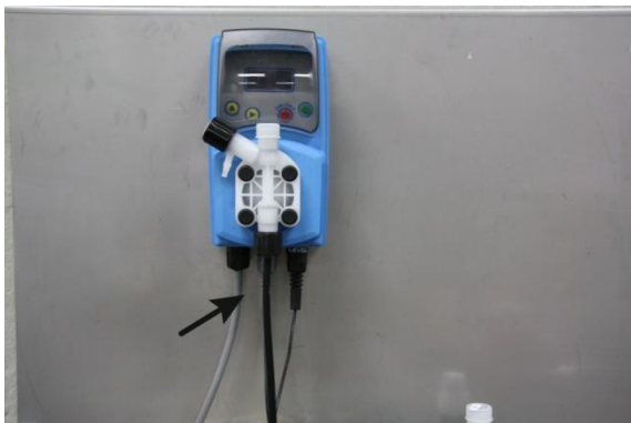
Imagen 3: Conectar tubo flexible aspiración
