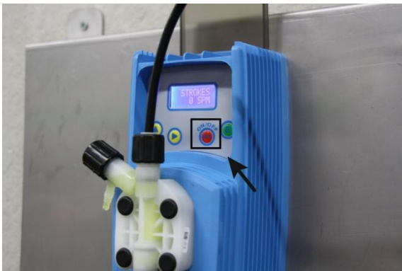
Figur 5: Tænd for pumpen
