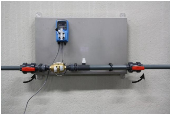
Afbeelding 1: Opendraaien kogelkranen
