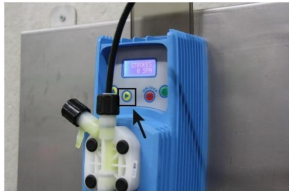
Abbildung 8: Druckluftschlauch befüllen
