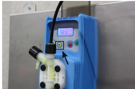
Figura 8: Riempire il condotto in pressione
