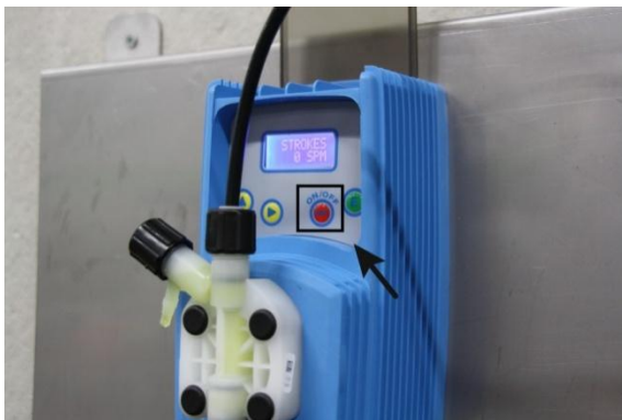
Figura 5: Avviare la pompa
