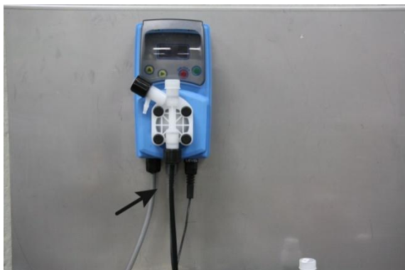
Figura 3: Collegare il tubo di aspirazione
