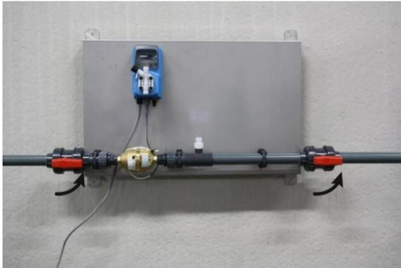
Abbildung 1: Kugelventile öffnen
