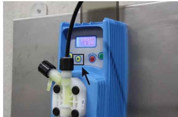
Imagen 8: Llenar el conducto de presión
