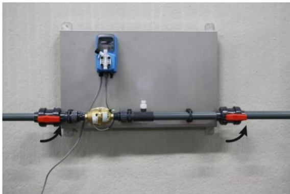
Figur 1: Åbn kugleventileme
