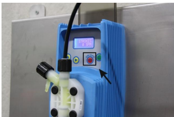
Afbeelding 5: Aanzetten van de pomp
