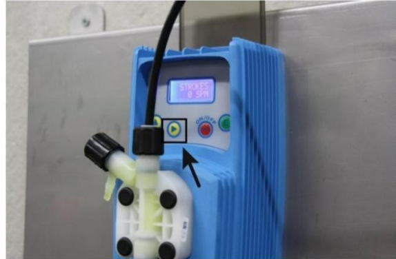
Ill. 8: Remplir la tubulure de sortie
