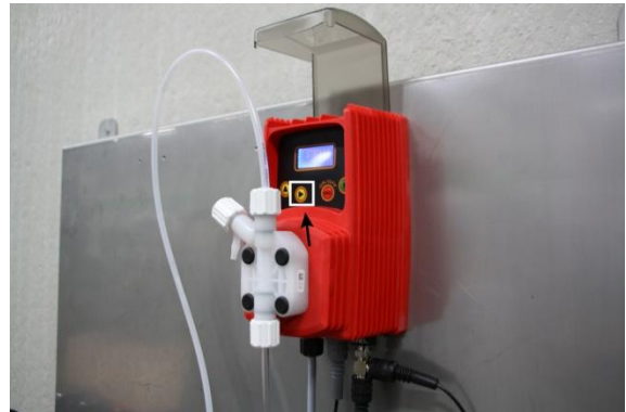
Figura 8: Riempire il condotto in pressione
