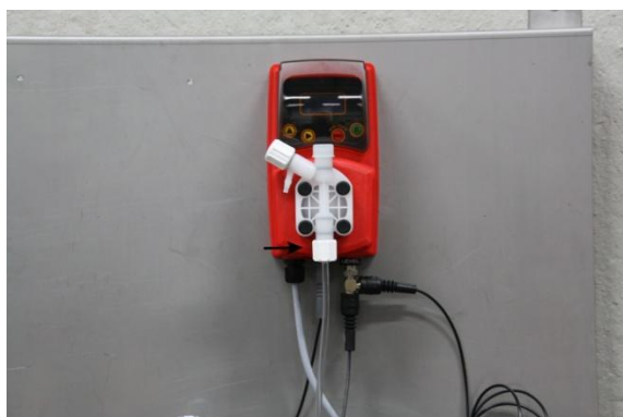
Figura 3: Collegare il tubo di aspirazione
