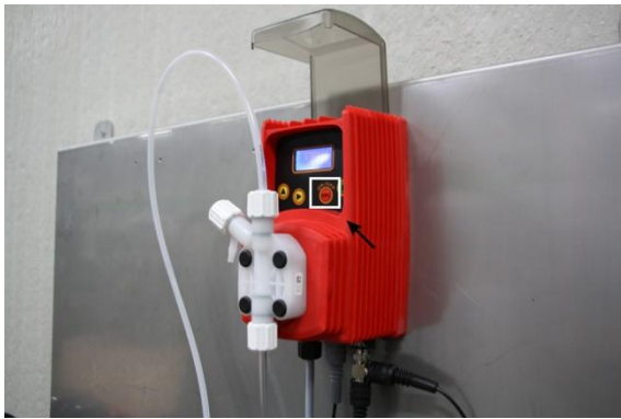
III. 5: Mettre la pompe sous tension
