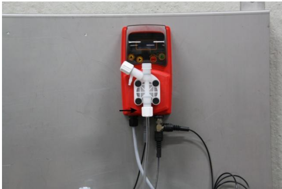
Afbeelding 3: Aansluiten aanzuigslang
