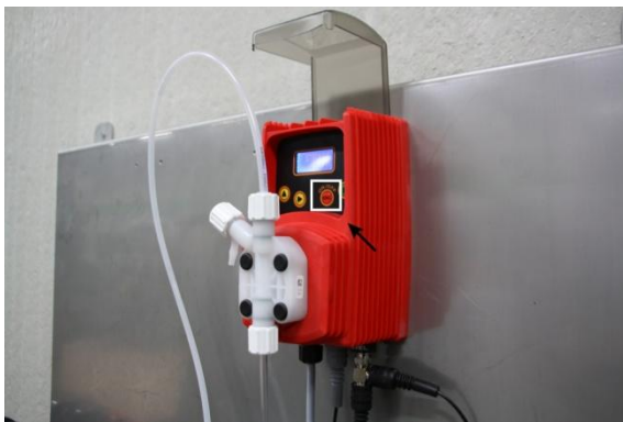
Afbeelding 5: Aanzetten van de pomp
