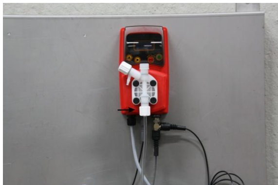
Figur 3: Tilkobl sugeslangen
