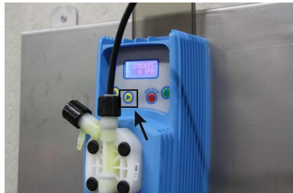
Figura 12: Riempire il condotto in pressione
