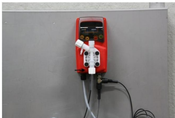
Figur 7: Tilkobl sugeslangen
