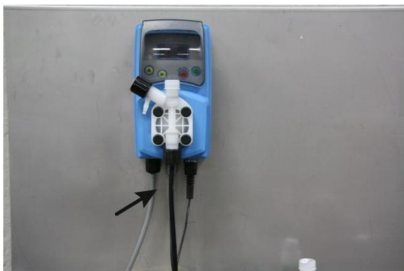
Figur 3: Tilkobl sugeslangen
