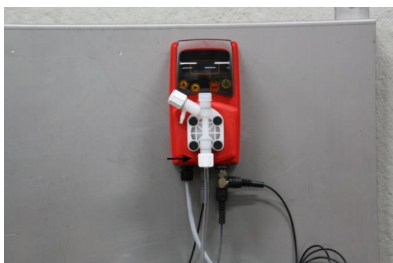
Imagen 7: Conectar tubo flexible aspiración
