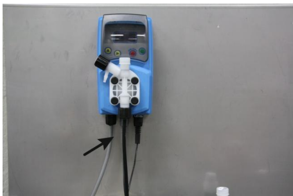
Afbeelding 3: Aansluiten aanzuigslang
