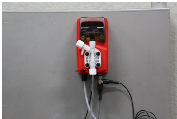
Afbeelding 7: Aansluiten aanzuigslang
