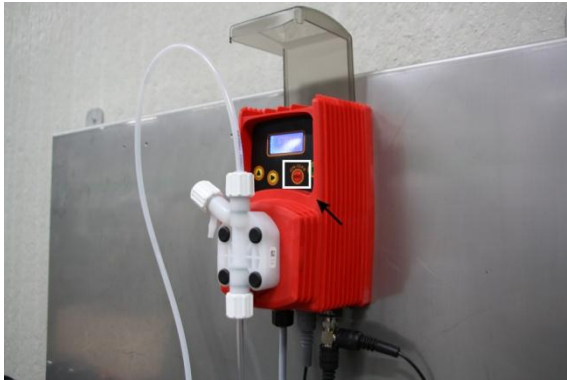
Afbeelding 13: Aanzetten van de pomp
