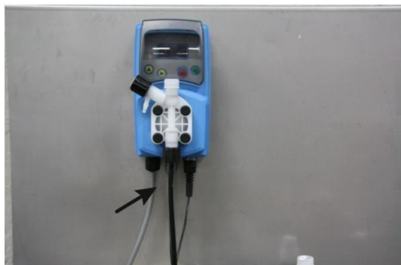
Ill. 3: Raccorder le tuyau d'arrivée
