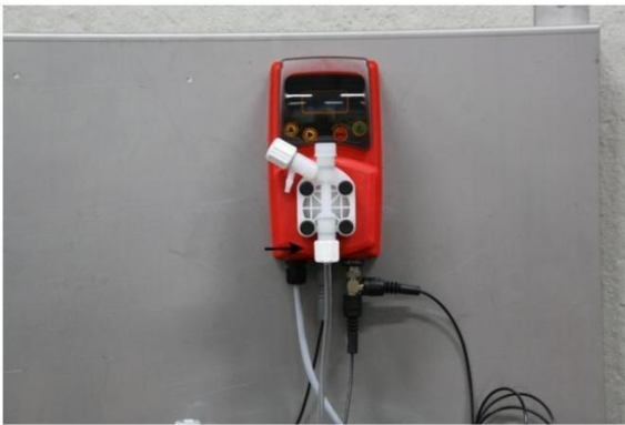
Ill. 7: Raccorder le tuyau d'arrivée
