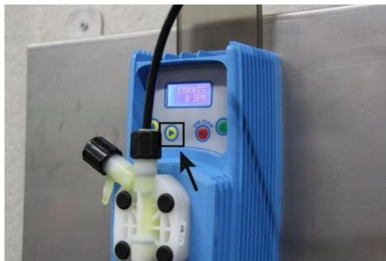
Ill. 12: Remplir la tubulure de sortie
