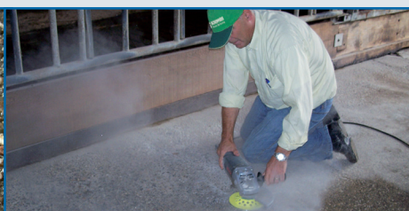
2. Poncer le sol si nécessaire
