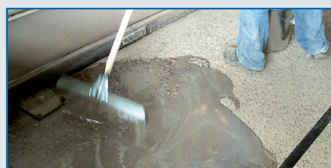
7. Étaler le mélange sur la surface à recouvrir
