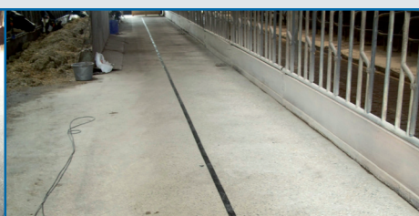
5. Délimiter la zone à recouvrir avec du ruban adhésif
