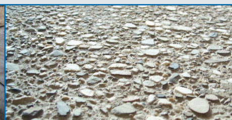
3. Sol après ponçage
