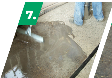
Pour the mix over the floor
