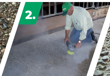
2. Poncez le sol si nécessaire
